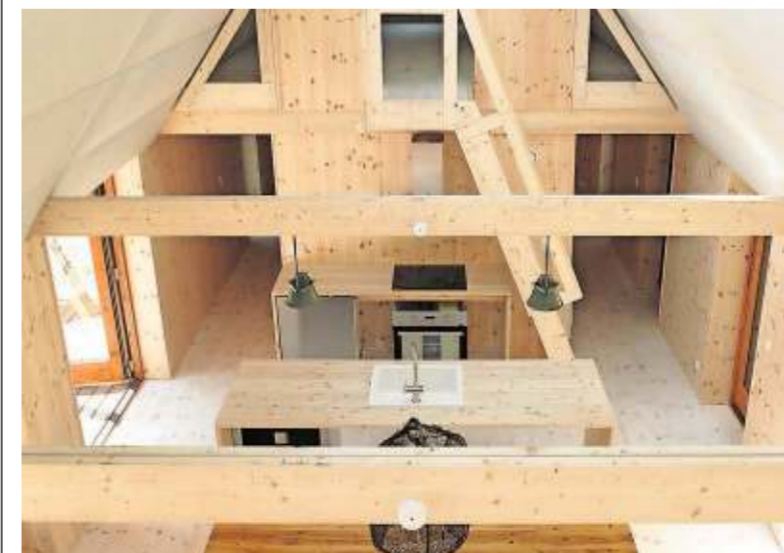
Assemblage van de houten prefab elementen tot een compleet huis kost twee man een dag of vijf werk.
