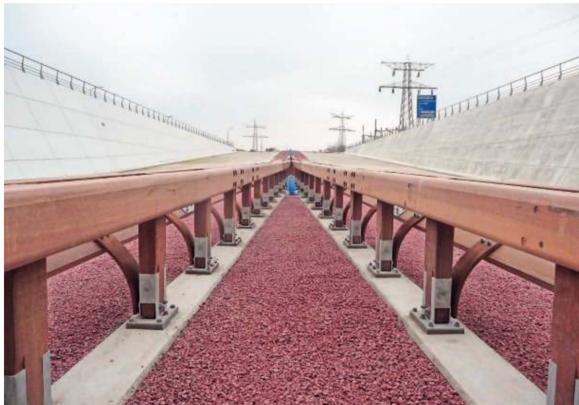
Houten geleiderails scoren op veel technische onderdelen even goed als staal of zelfs beter. Foto: Centrum Hout
