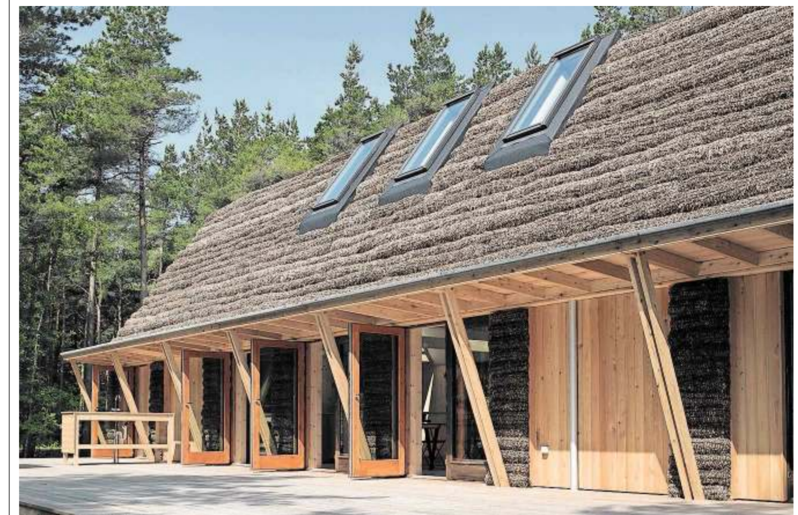
De Deense vakantiewoning heeft een bitumen dak. Daarop liggen 40 centimeter dikke strengen samengepakt zeegras.
